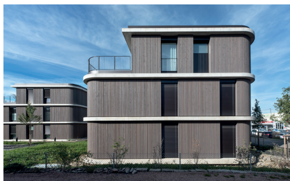
Rotondo Gipf-Oberfrick 15 Eigentumswohnungen
