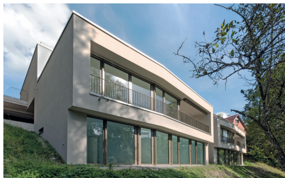
Hammerstätte Gipf-Oberfrick fünf Einfamilienhäuser
